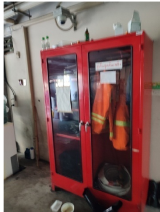
ตู้เก็บสายฉีดน้ำดับเพลิง และตู้เก็บอุปกรณ์และชุดผจญเพลิง และถังดับเพลิงเคมีมือถือ
