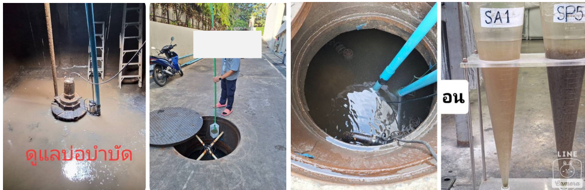
ภาพที่ 5-34 ดูแลซ่อมบำรุงระบบน้ำบาดน้ำเสีย
